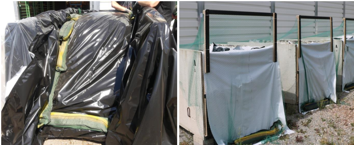
Abbildung 42: Holzhackschnitzelsilo beim Aufbau inkl. Silofolie, Unterziehfolie und Sandsäcke (links). Lagerung in abgedichteten Silos am Betriebshof des TFZ inkl. Sonnen- und Vogelschutz (rechts)
