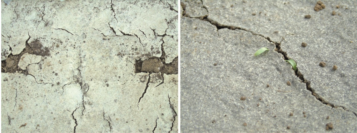
Abbildung 67: Rissbildung und Beikrautdurchwuchs 8 Tage nach der Applikation, Versuch Einlegegurke, Niederbayern, 2022
